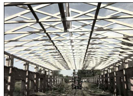
AREN SO aitu mītnes jumts. Jumta kopņu montāža.
