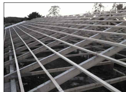
AREN SO aitu mītnes jumts. Jumta klājs ar latām.
