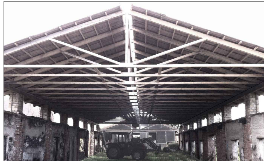
AREN SO aitu mītnes jumts. Attēlā redzams jumta kopnes K10.6 ar laidumu 10.6m, un soli 1.2m. Foto no 2012. gada vasaras.
